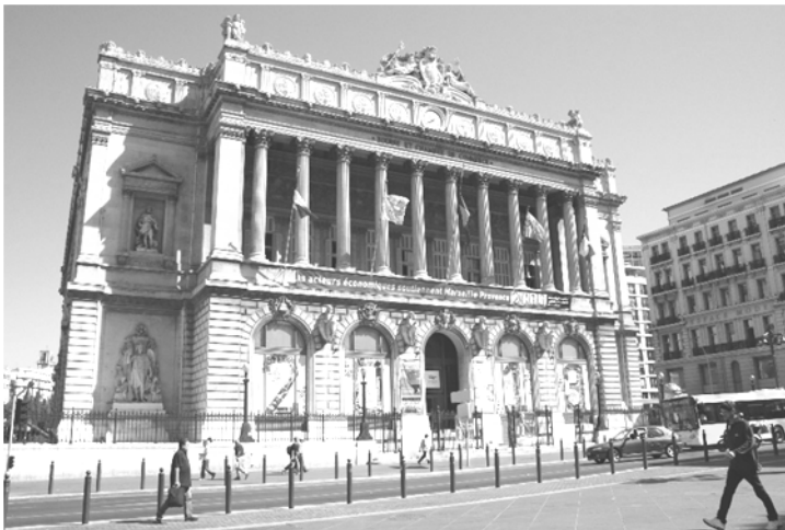
Doc. 1 : Façade du Palais de la Bourse, Marseille.
